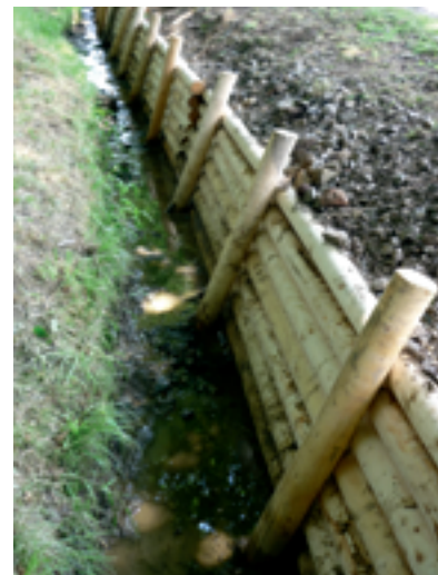
Durchgeführte Bachsanieierungsarbeiten der JVA Chemnitz im Zuflussbereich des Anlagenteiches im OT Callenberg.
