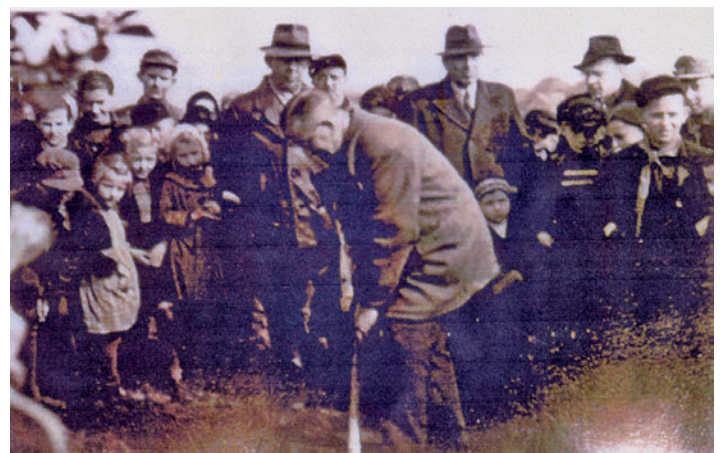
1. Spatenstich für die Nickelerzgrube Obercallenberg am 1. März 1952. Werkdirektor Greif, Techn.Ltr. Herr Rudolph (mit Spaten) und die Herren Groner und H.Vogel (von links nach rechts)
